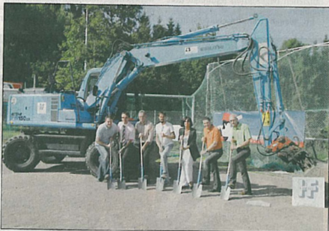
Legten gemeinsam Hand an beim „ersten Spatenstich“: Steffen Fuchs von der Baufirma Hermann Fuchs, Karl Hilsenbek, Hermann Weber, stellvertretender Fördervereinsvorsitzender Bernd Schmidt, Stadträtin Gisela Mayer, Andreas Hunke und Udo Bäuerle (von links). (Foto: Klemm)
